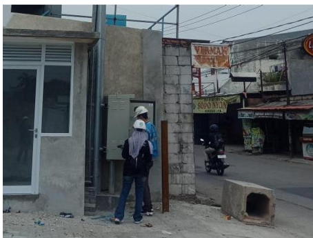
Gambar 7. Pengukuran beban pada gardu distribusi
