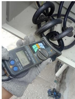
Gambar 2. Pengukuran Arus Pada Gardu
