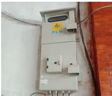
Gambar 6. Pemasangan box APP pada toserba
