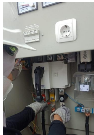
Gambar 1. Pengukuran Tegangan Pada Gardu
